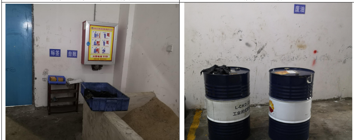
废旧机油库台账存放处及消防措施
