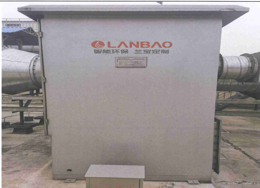
炼胶烟气注入式等离子处理设备（共九套）
